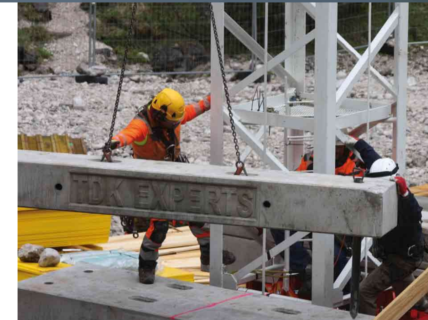
(Abb. oben): Beim Bauprojekt der Höllentalangerhütte des DAV mußten die Kranteile mit dem Helikopter angeliefert werden, da die Lage nicht mit Fahrzeugen zu erreichen ist.
